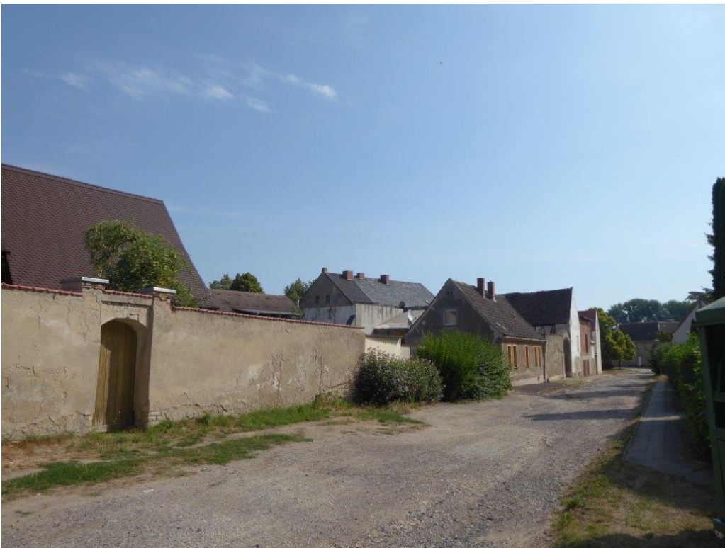
Abbildung 20: Notwendige Straßensanierung am Beispiel (Foto OT Biere) 29
