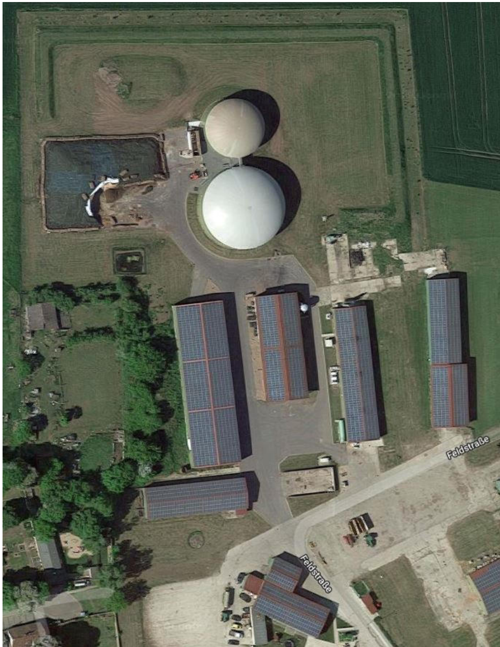
Abbildung 1: Luftbild der Anlage
