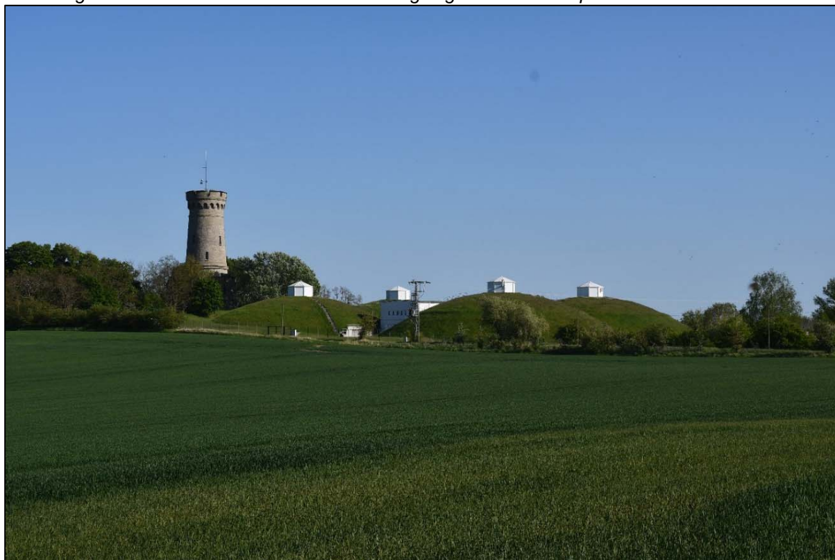
Abbildung 3: Blick auf den Bismarkturm mit vorgelagertem Wasserspeicher
